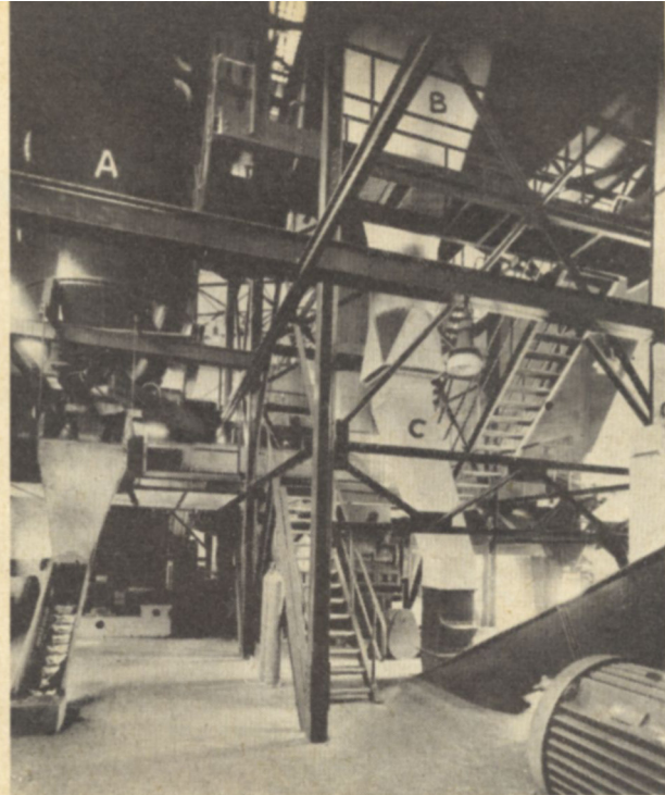
Teilansicht der Anlage
